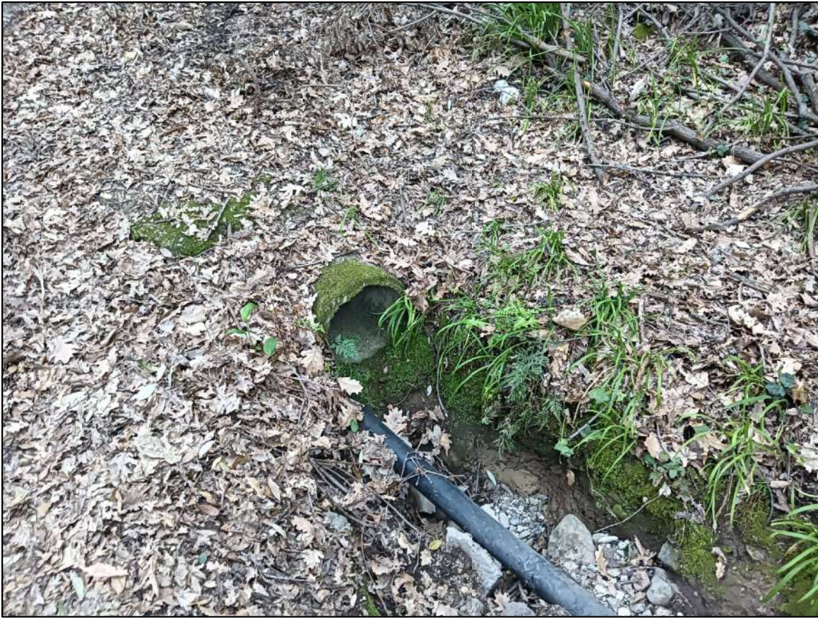
Foto 8 - Cavalca fosso e tubazione rete idrica esistente
