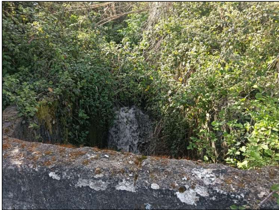
Foto 2: Imbocco Rio Matta Fresaghe / canale tombato
