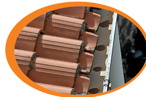
Controlla periodicamente le grondaie mantenendole libere e pulite
